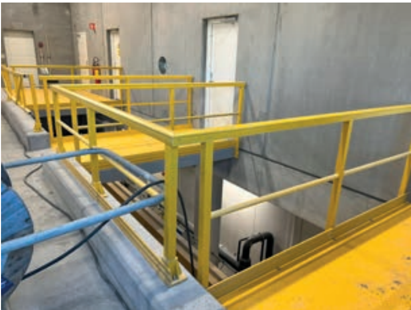
Glassfiberstruktur med rekkverk og gitterrist/tåreplate hos Salmon Evolution.
