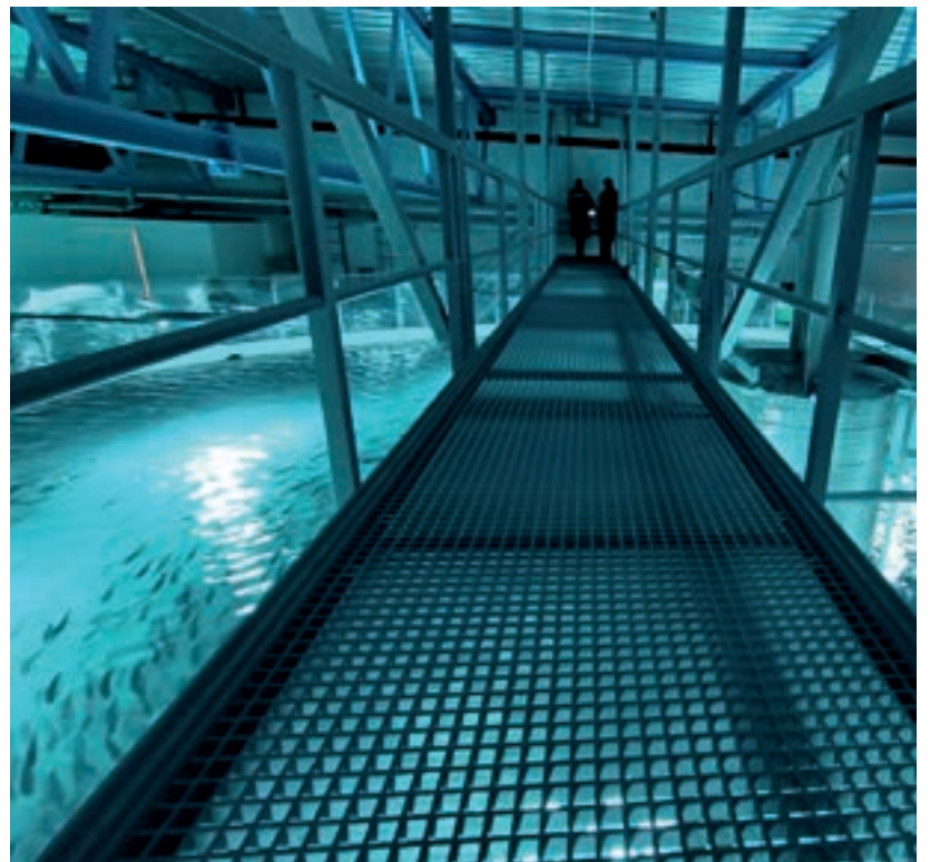
Gangbroer i glassfiber egner seg utmerket til fuktige miljø. Foto: Hofseth Aqua, Jannicke.
